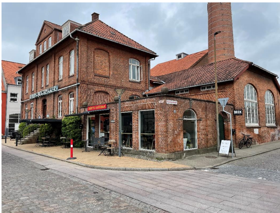
Figur 6-1 Serviceerhverv i gammel industribygning på Gravene i Haderslev
