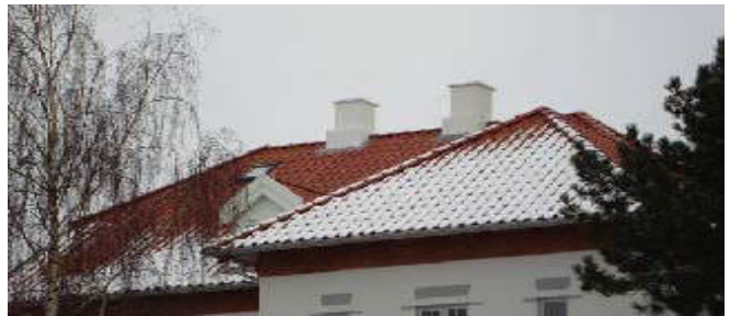
Billede: Antenne kamufleret i skorsten
