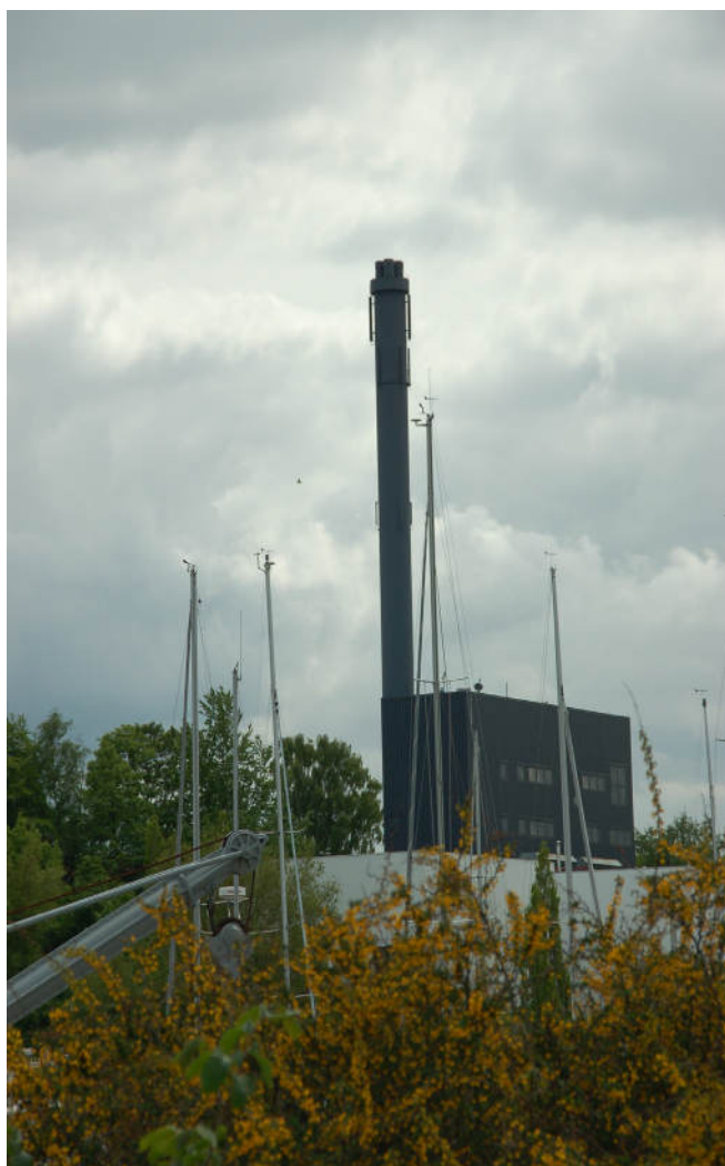
Billede: Antenner på skorsten
