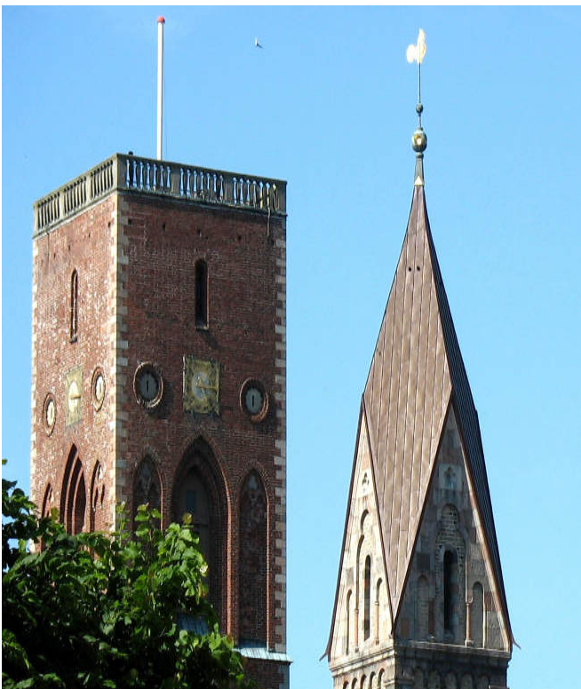
Billede: Flagstangsmast på Ribe Domkirke
