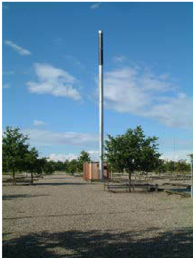
Billede: Rørmast på p-plads
